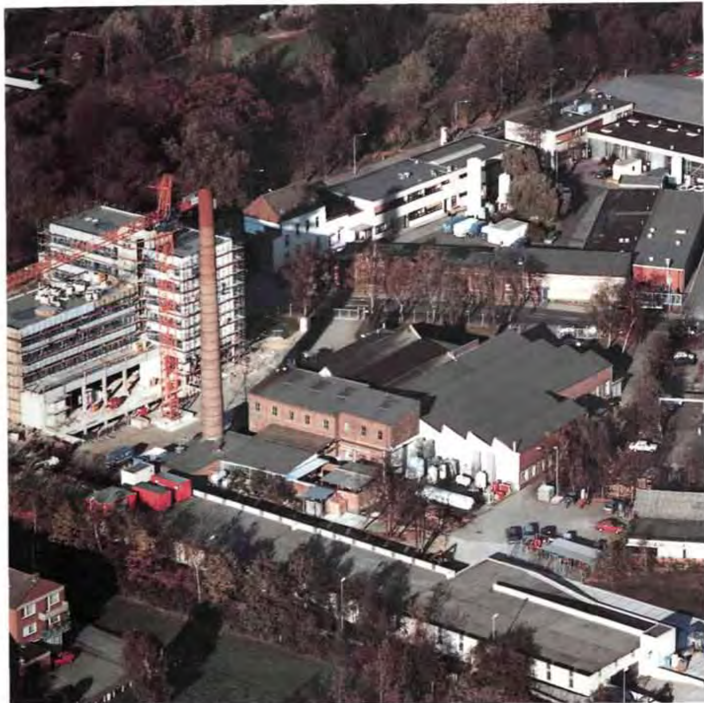
Im Technischen Zentrum Krefeld arbeiten im Berichtsjahr rund 150 Mitarbeiter in Gase-Forschung und -Entwicklung. Nach Fertigstellung des neuen Gebäudes werden etwa 120 weitere Mitarbeiter einziehen.
