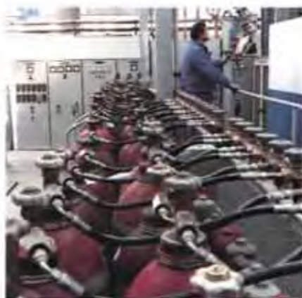
Unsere Tochtergesellschaft Messer Griesheim Italiana hat für die Ausweitung des Gasgeschäfts ein Umlüftungswerk in Turin errichtet.
