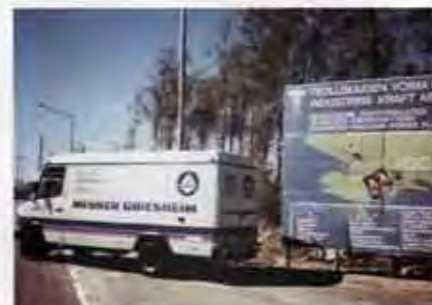
Unser Stickstoff-Service war zum Rohrfrostfen auch in Finnland gefragt. Das wirtschaftliche Verfahren ermöglicht eine erhebliche Zeitersparnis bei der Reparatur von flüssigkeitsführenden Rohrleitungen
