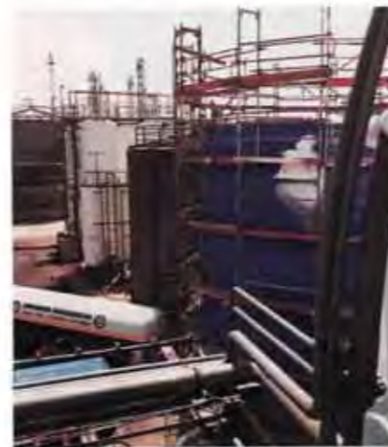
Flüssiger Stickstoff hat sich in der industriellen Fertigung, zum Beispiel beim Entgummieren eines 500-Kubikmeter-Lagerbehälters, als universelles, umweltfreundliches Hilfsmittel erwiesen
