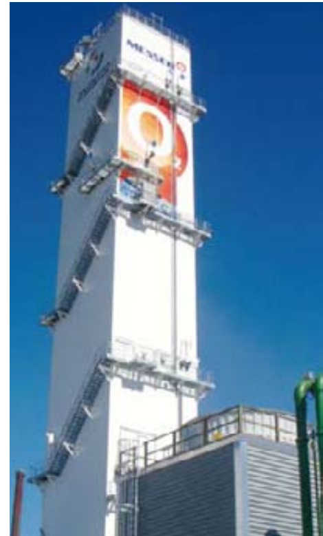
Die größte Produktionsanlage von Messer in Europa steht in Salzgitter, Deutschland.
