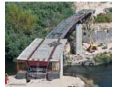
Metaldeza setzt Gase in Flaschen beim Brückenbau ein.
