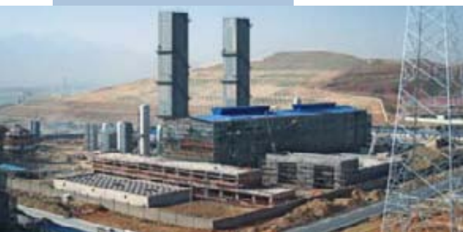
Neue Luftzerlegungsanlagen am Standort der Pangang Group in Xichang
