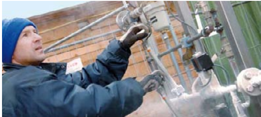
Die Menge des flüssigen Stickstoffs kann bei der Zementkühlung exakt reguliert werden.
