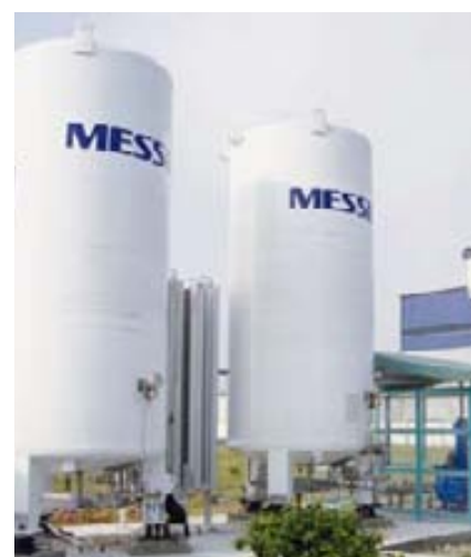
Thai Summit bezieht seine Gase nun aus Kaltvergasern.
