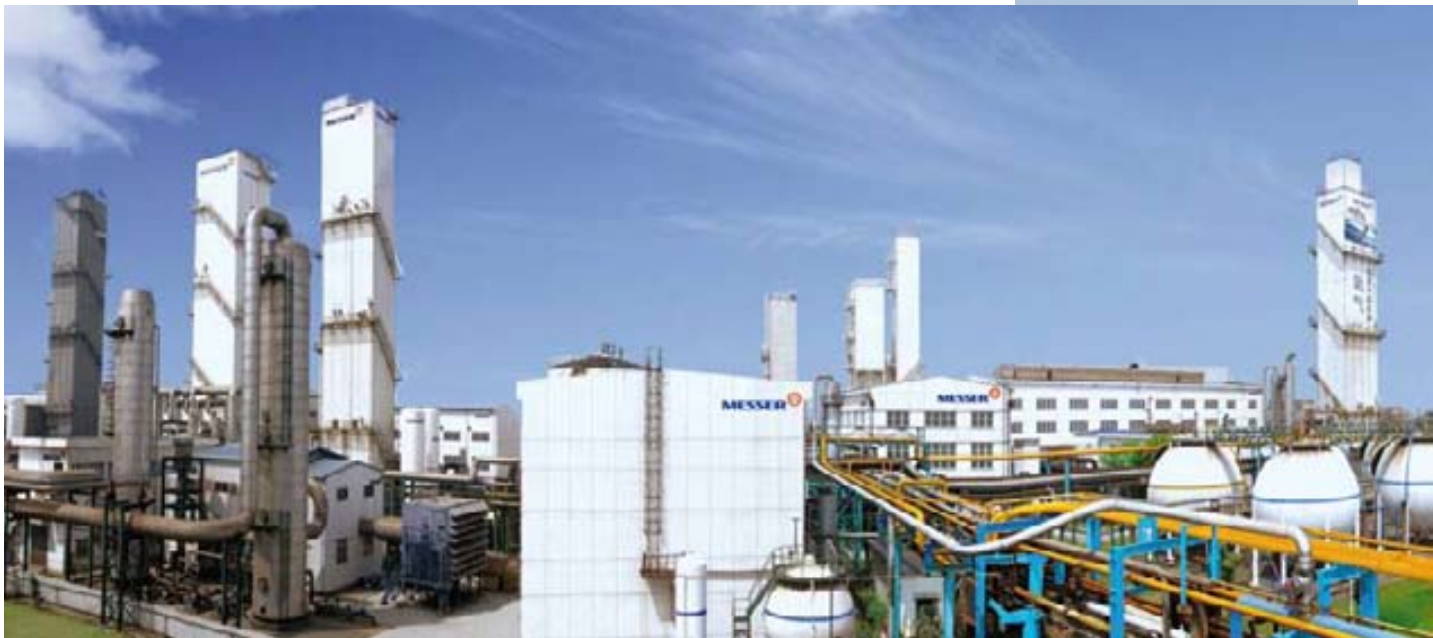
Produzieren 40.000 Normkubikmeter Sauerstoff pro Stunde: die neuen Luftzerlegungsanlagen bei Xiangtan Iron and Steel.
