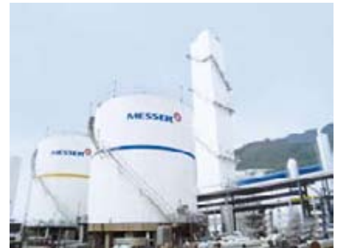
Die Gesamtkapazität der neuen Luftzerlegungsanlagen liegt bei 35.000 Normkubikmetern pro Stunde.
