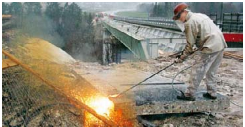
Beim Betonschneiden mit der Sauerstoffflanze entstehen Temperaturen bis zu 2.500 Grad Celsius.
