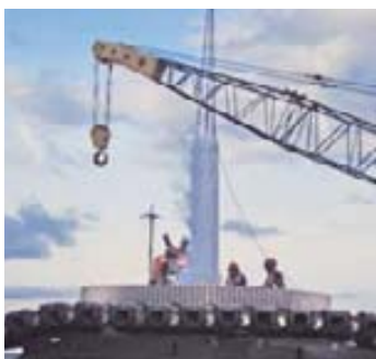
Stickstoffkälte spielte bei der Montage dieser gigantischen Bagger-Hauptachse eine wichtige Rolle.
