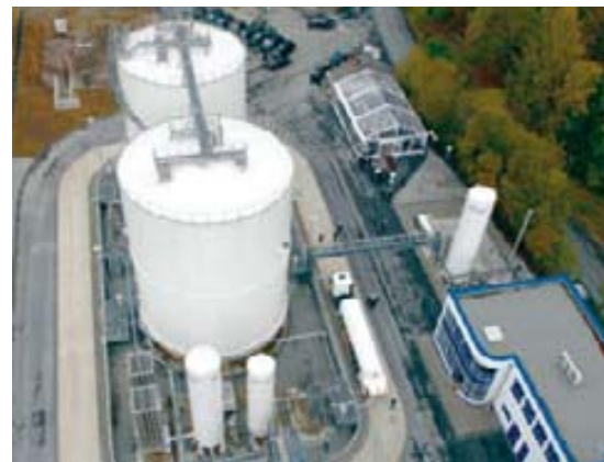
Aus luftiger Höhe: die Luftzerlegungsanlage in Siegen, Deutschland
