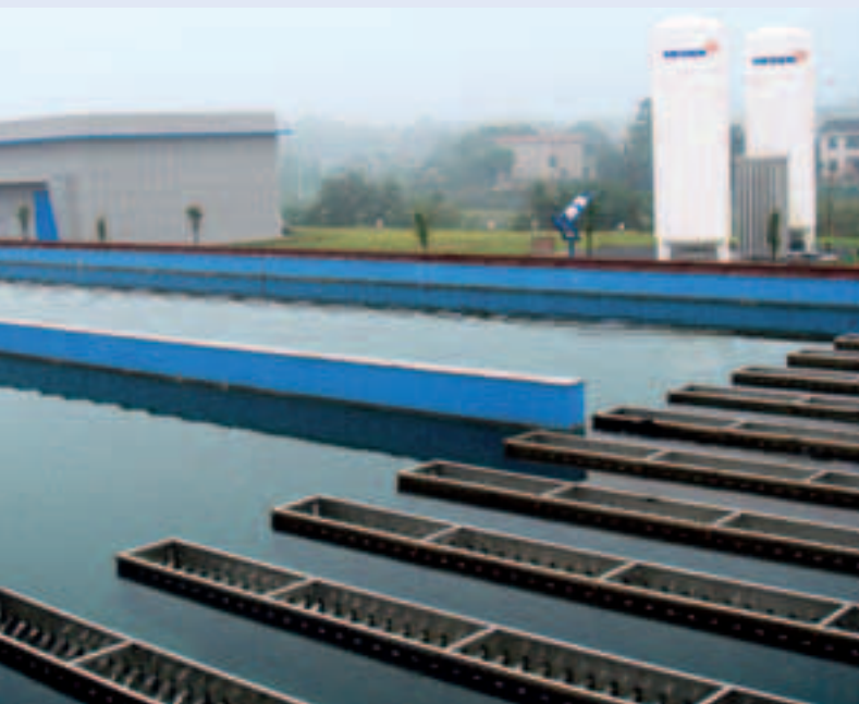
Riesige Dimensionen: Bis zu 100.000 Tonnen Wasser reinigt das Wasserwerk von Changsha am Tag.
